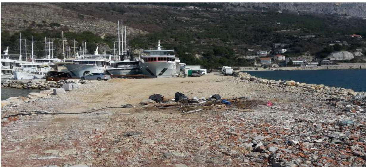
Slika 1.1.-7.: Izgled postojećeg istočnog gata (primarni gat)
